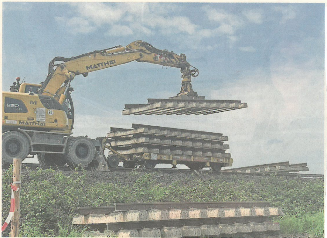
Baustelle Schienentrasse Fehmarn: Die Teilstücke werden von einem Gleisbagger aufgenommen und zu einem zentralen Lagerplatz transportiert.
