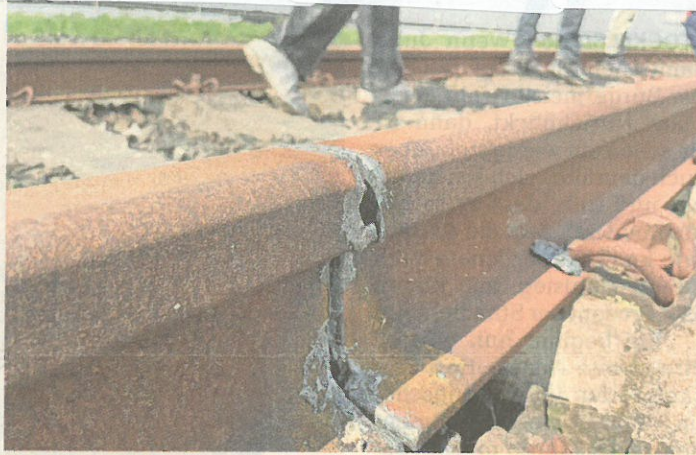
Die Gleisstücke sind für den Abtransport „zugeschnitten“.
